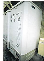
図1.23 蒸気発生器 (加湿器)
