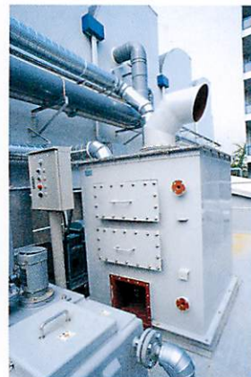
図1.33 スクラバー(有機系統)
