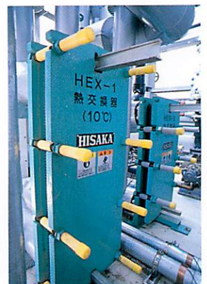
図1.30 ステンレス製プレート式熱交換器
