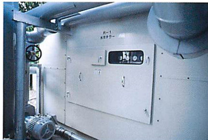
図1.21 水冷式チリングユニット
