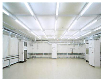
プラズマCVD室 (Class 1) Cr 2 O 3 不動態処理配管系を採用した世界最高性能の超高純度ガス供給系(成膜用)を備えています。
