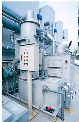
図1.32 スクラバー(可燃系統)
