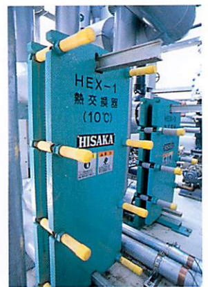
図1.30 ステンレス製プレート式熱交換器
