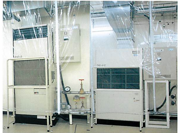
図1.19 空気調和器 (水冷式パッケージユニット)
