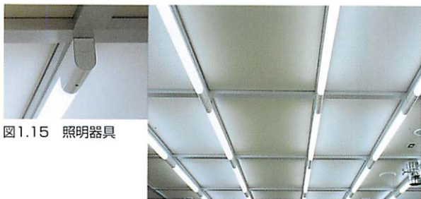
図1.16 アルミフレームシステム天井
