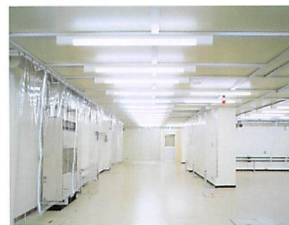
ニュープロセス室 (Class 1) 装置冷却用一次純水、雑排気用ポートなどのユーティリティを備え、今後開発される新しい装置を設置するためのスペースです。正面はEEM室出入口のエアシャワーを示しています。
