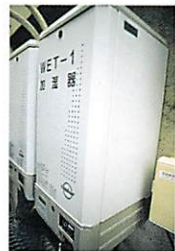
図1.23 蒸気発生器 (加湿器)
