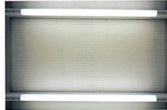
図1.6 今回採用したULPAフィルター
