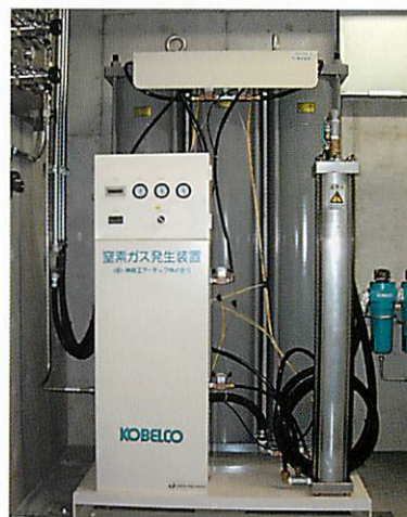
図2.20 PSA式窒素ガス発生装置
