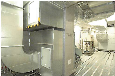
全熱交換器および外気調和機
