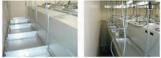
図1.16 低圧損サイレンサー付きFFU
