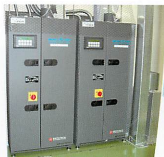
図2.17 ゲッター式ガス精製装置
