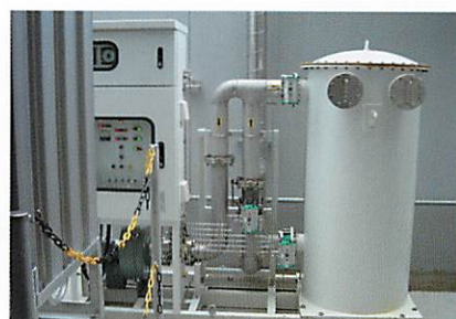
図2.19 緊急保安装置
