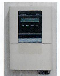
図4.5 非常通報設備
