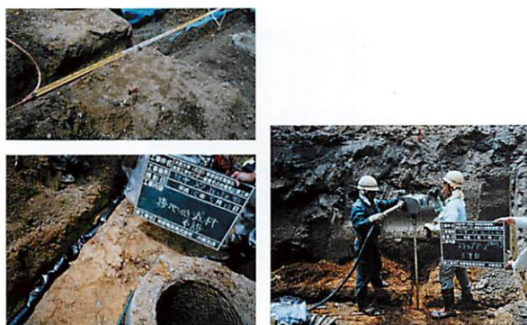
図1.4 特殊メッシュアースおよびステップアースの施工
